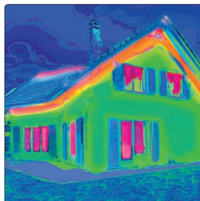
Die rote Farbe beweist: Wärme geht hauptsächlich durch die Fenster verloren
