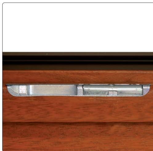
Formschön und praktisch: eingelassene Beschläge erleichtern das Reinigen des Fensters
